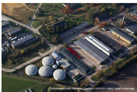
Biogasanlage im Industriepark Nord. Westfalen
