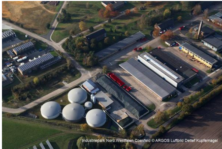
Biogasanlage im Industriepark Nord.Westfalen
