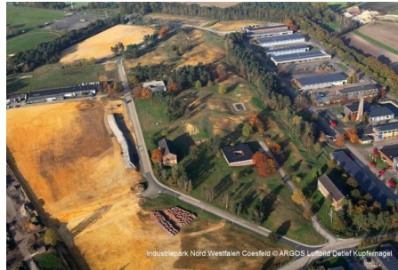
6.3 ha Industriefläche im Industriepark Nord.Westfalen
