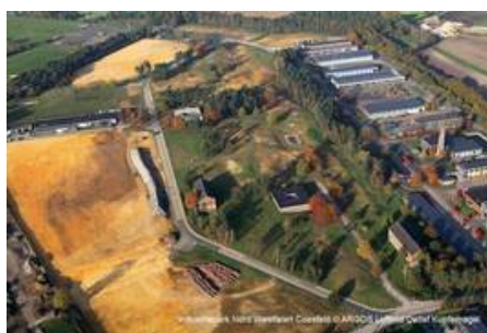
6.3 ha Industriefläche im Industriepark Nord.Westfalen
