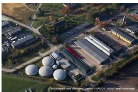
Biogasanlage im Industriepark Nord.Westfalen
