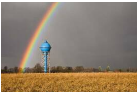
Historischer Ahleener Wasserturm
