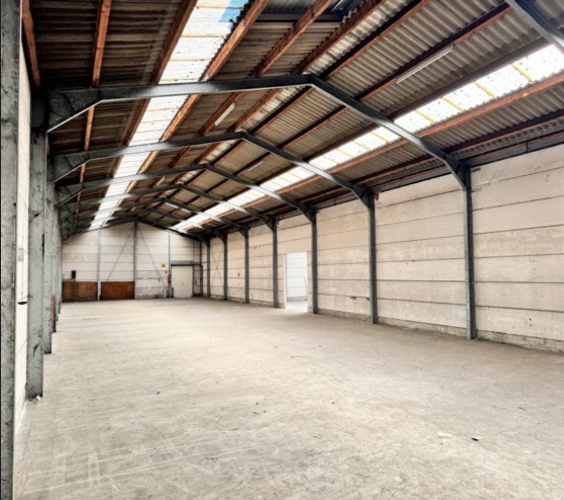
Halle mit Rampe
